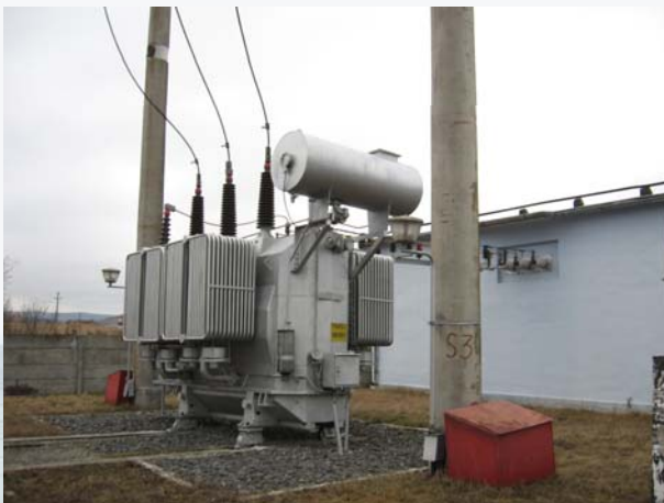
Trafo 110/20kV fost si actual
