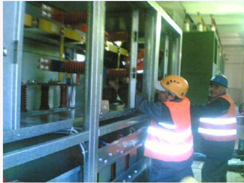
Celulele de masura in PA Aeroport 20kV-ansamblu celula
