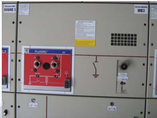
Celulele de masura in PA Aeroport 20kV-ansamblu celula
